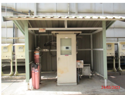
รูปที่ 4 อุปกรณ์การตรวจวัดการระบายมลสารจากปล่องอัตโนมัติ (CEMs)
