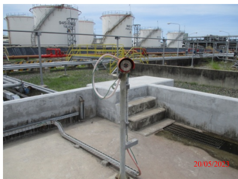
รูปที่ 60 Gas Detector บริเวณถังเก็บสำรอง
