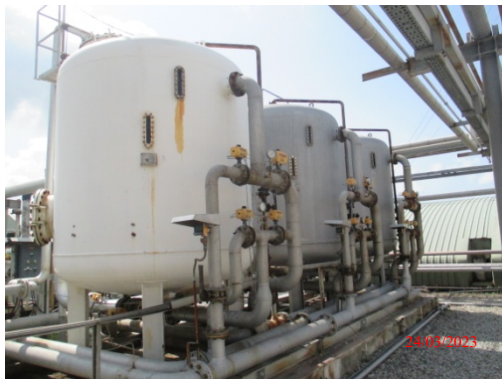
รูปที่ 24 Sand Filters
