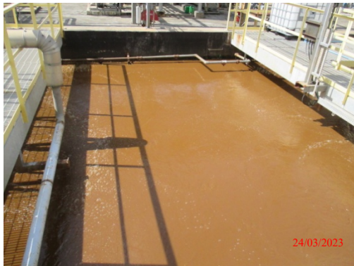
รูปที่ 22 Aeration Tank
