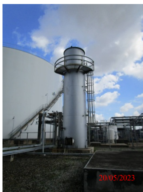
รูปที่ 6 ระบบกำจัดไอสารไอโธคาร์บอน (Vapor Disposal System) บริเวณลานถังเก็บกัก
