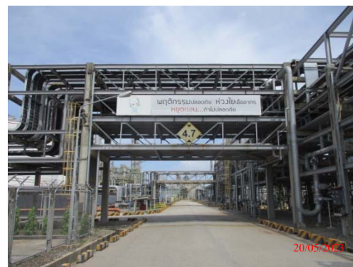
รูปที่ 80 ท่อรับส่งวัตถุดิบ-ผลิตภัณฑ์วางตัวบน Pipe Rack และ Pipe Bride
