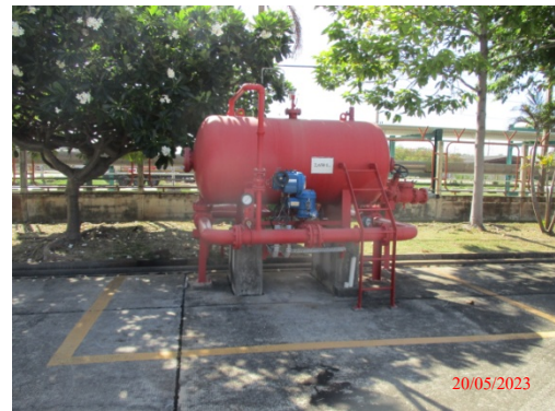
รูปที่ 67 ระบบโฟมดับเพลิง
