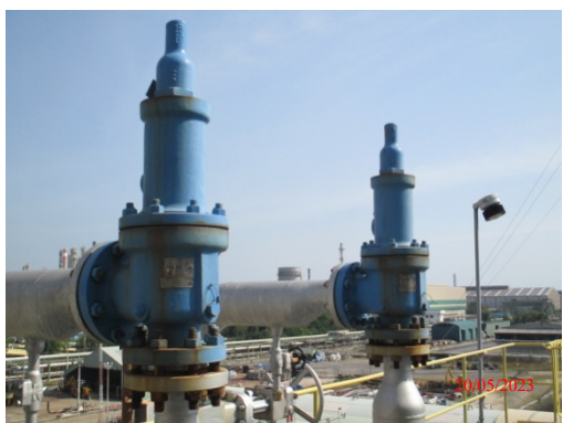
รูปที่ 83 Safety Valve บนท่อขนส่ง
