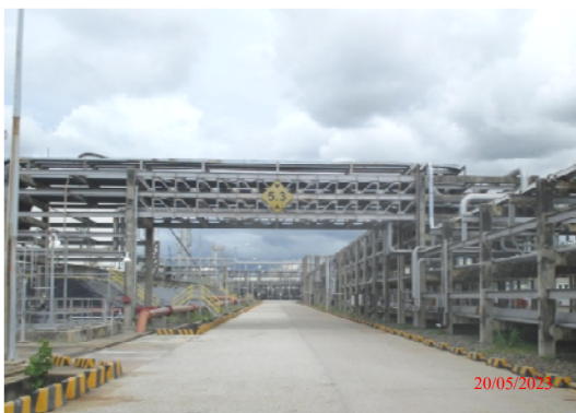
รูปที่ 80 ท่อรับส่งวัตถุดิบ-ผลิตภัณฑ์วางตัวบน Pipe Rack และ Pipe Bride
