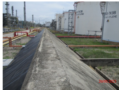
รูปที่ 57 คันกันล้นรอบถังเก็บสำรอง
