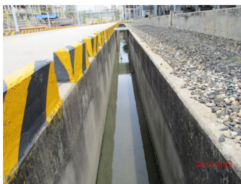
รูปที่ 32 Clean Water Sewer (CWS) บริเวณพื้นที่ลานถังเก็บกัก
