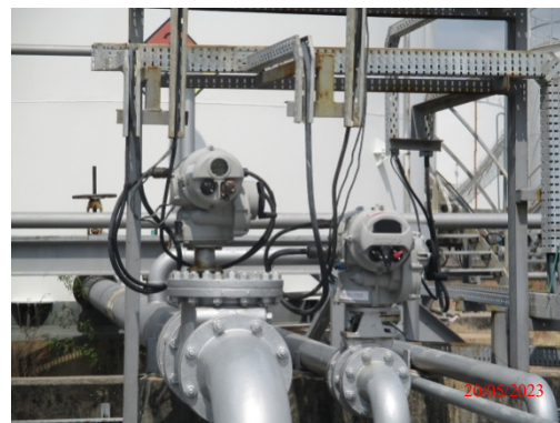
รูปที่ 84 Remote Shut-off Valve
