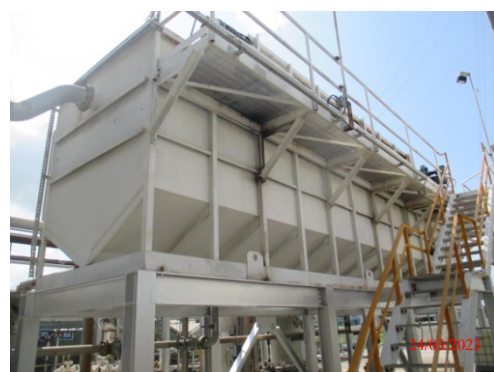
รูปที่ 21 Dissolved Air Floatation (DAF)
