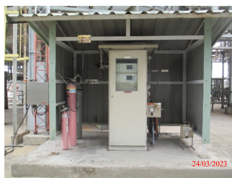
รูปที่ 4 อุปกรณ์การตรวจวัดการระบายมลสารจากปล่องอัตโนมัติ (CEMs)
