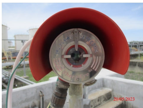
รูปที่ 62 Flame Detector
