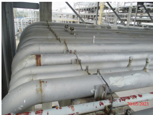
รูปที่ 82 สายดินบริเวณท่อขนส่ง
