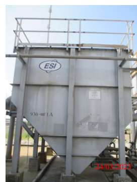
รูปที่ 15 CPI Separator
