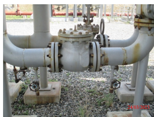
รูปที่ 87 Check Valve
