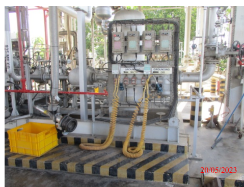
รูปที่ 65 Grounding บริเวณ Loading Rack
