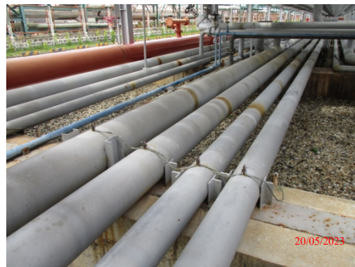
รูปที่ 82 สายดินบริเวณท่อขนส่ง
