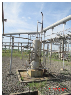
รูปที่ 2 ระบบกำจัดไอสารไฮโดรคาร์บอน (Vapor Disposal System)
