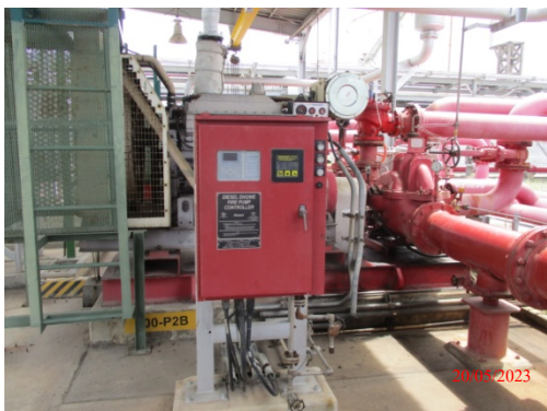
รูปที่ 73 ปั๊มน้ำดับเพลิง แบบ Diesel Pump
