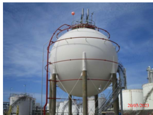
รูปที่ 79 ระบบฉีดพรมน้ำ บริเวณถังเก็บสำรอง
