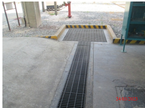
รูปที่ 11 Surface Water Sewer (SWS)
