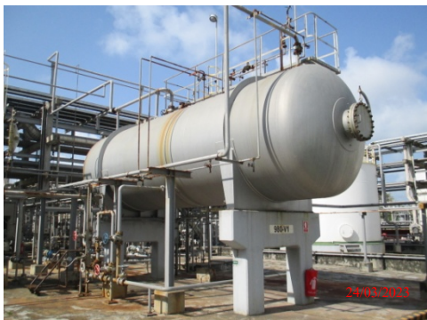
รูปที่ 16 ระบบ Neutralization Drum (980-V1)
