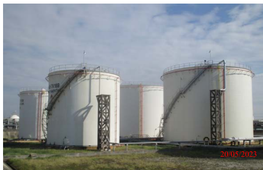
รูปที่ 5 ถังเก็บสารไอโธคาร์บอนชนิด IRFN และชนิด CRN
