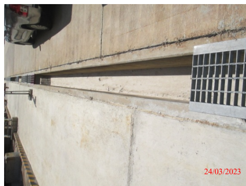
รูปที่ 13 Clean Water Sewer (CWS)
