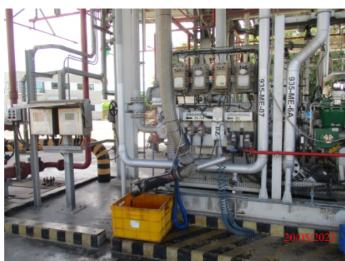
รูปที่ 64 Vapor Return Arm บริเวณ Loading Rack
