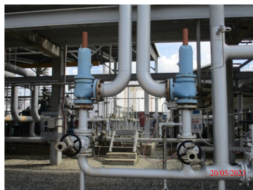
รูปที่ 83 Safety Valve บนท่อขนส่ง
