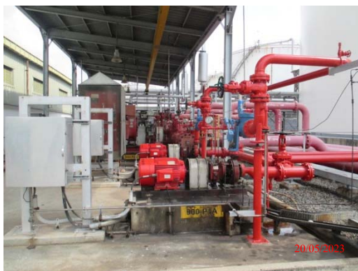
รูปที่ 78 บัมพ์น้ำดับเพลิงแบบไฟฟ้า
