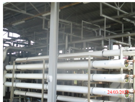
รูปที่ 27 ระบบ UF&RO
