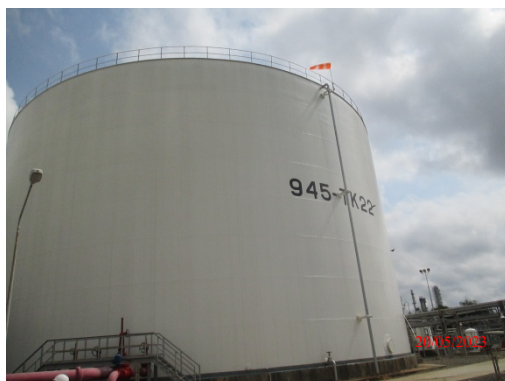
รูปที่ 69 ถังเก็บน้ำดับเพลิง
