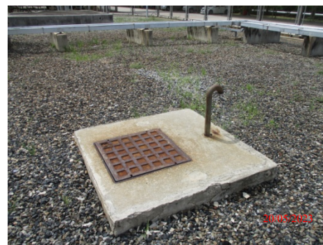
รูปที่ 31 Sanitary Sewer (SS) บริเวณพื้นที่ลานถังเก็บกัก
