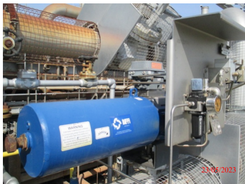
รูปที่ 84 Remote Shut-off Valve
