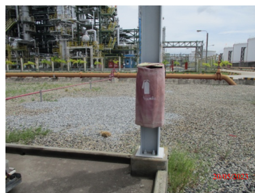
รูปที่ 71 เครื่องดับเพลิงชนิดผงเคมีแห้ง
