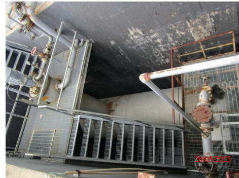
รูปที่ 29 Closed Aromatics Drain (CAD) บริเวณพื้นที่ลานถังเก็บกัก
