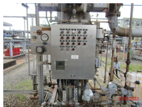
รูปที่ 59 หน้าจอควบคุมระบบ การเผาไหม้สารไฮโดรคาร์บอน
