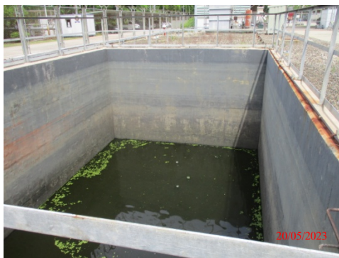
รูปที่ 30 Accidentally Oil Contaminated (AOC) บริเวณพื้นที่ลานถังเก็บกัก
